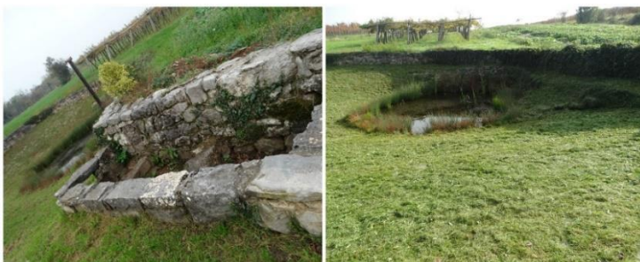
Obnovljen peskolovec ob Čotnem kalu
