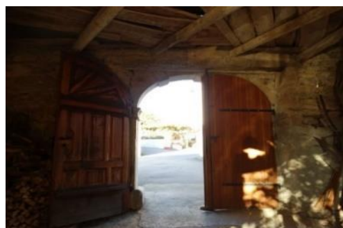
Slika 7: Pogled skozi kolono z Zančevega borjača
