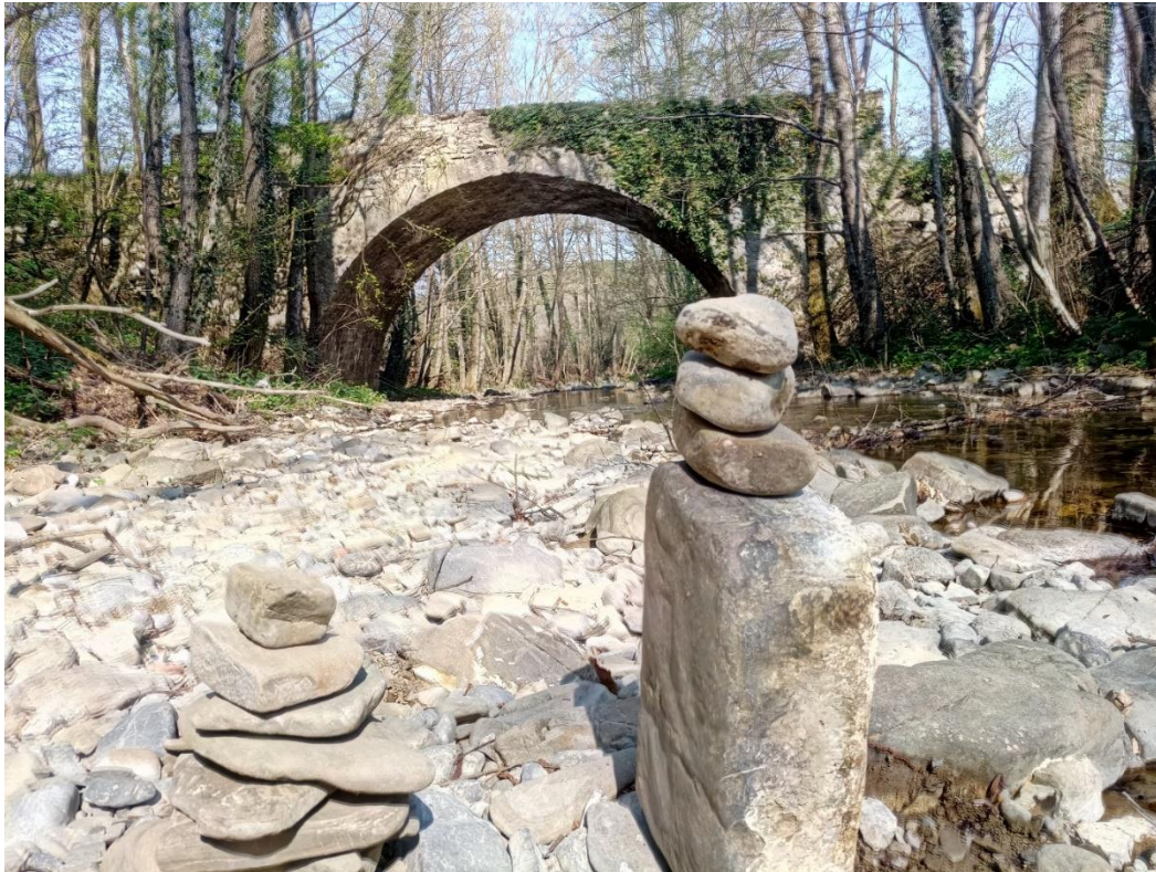
Potok Branica pri Gabrskem mostu
