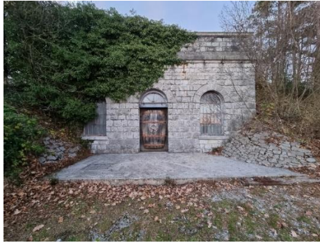
Slika 9: Štirna nad predorom za potrebe železnice – parnih lokomotiv
