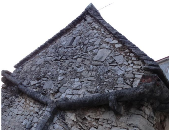
slika 21: Kamniti žlebovi in streha krita s skrlami
